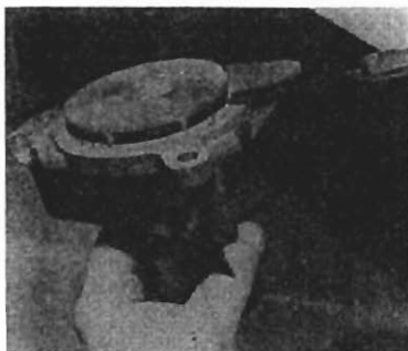
Control de la distancia de montaje de la turbina.
